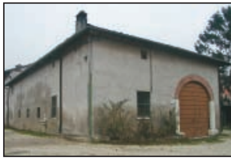
La Cascina Botà prima della ristrutturazione
